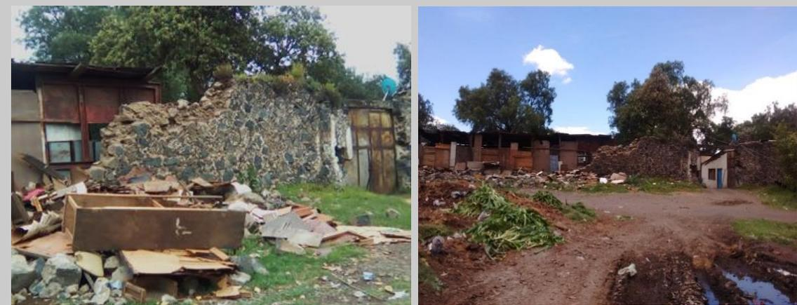
Fotografías que muestran los daños ocasionados en el casco de la Hacienda Santa Fe. Como es la demolición de paredes, a raíz del sismo del 19 de septiembre del 2017, y por antigüedad, asimismo se observa basura orgánica, e inorgánica y restos de madera por qué parte del espacio de la hacienda es utilizada como maderería.
