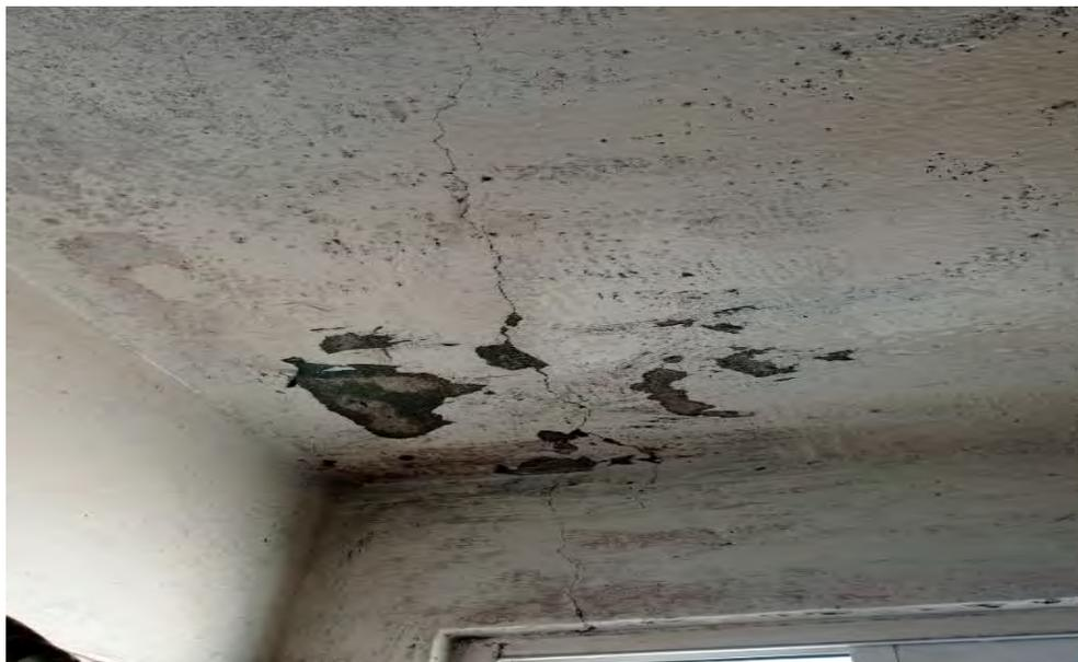
*Figura 12. Cuarteaduras en el techo del baño planta naja de vivienda de la sección Ex Hacienda Xico I. Fuente propia.*
