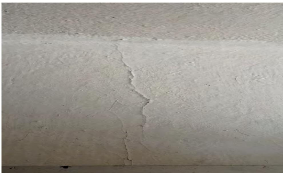
*Figura 13. Cuarteaduras en pared de baño de vivienda de la sección Ex Hacienda Xico I. El testimonio refiere que se presentó ese daño a su vivienda cuando su vecino estaba martillando para poner su espejo, siendo que comparten la misma barda del baño. Fuente propia.*
