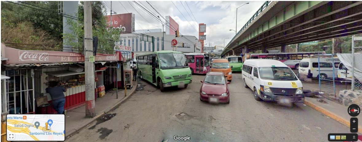
Imagen 1. Parte central del puente vehicular Los Reyes-Texcoco
