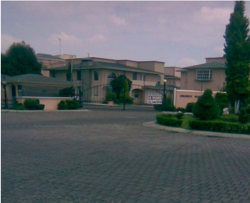
Foto 5. Residencial “Los Arcos”
