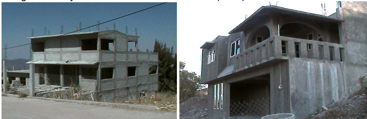
Fotografías 4.1 y 4.2 Casas en construcción en Ixpantepec Nieves.
