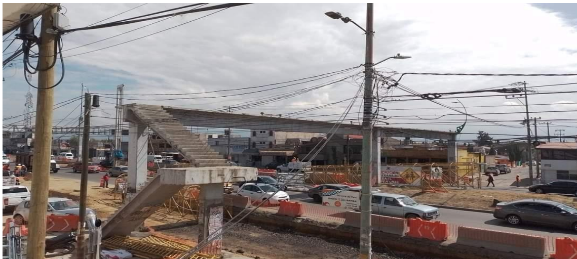
Figura 35. Fotografía del desmantelamiento del puente peatonal (Elaboración propia, 2022).
