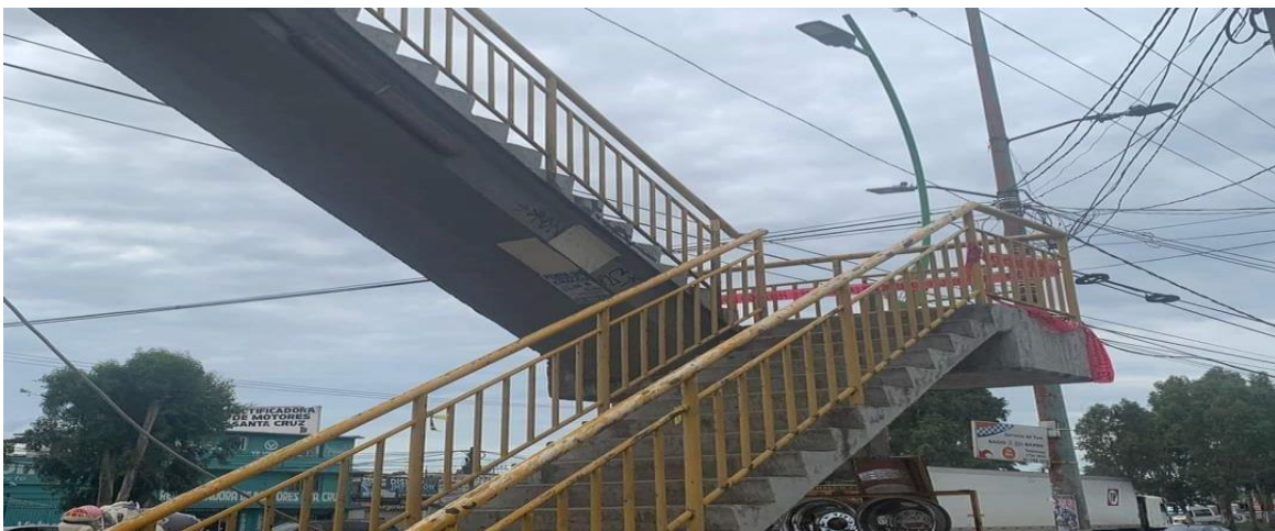
Figura 33. Fotografía del puente peatonal cerrado (Reporte Chalco, 2017).
