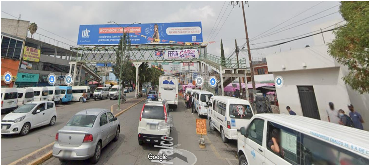
Figura 36. Fotografía del puente peatonal en el centro de Chalco (Google Maps, 2023).
