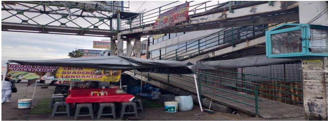
Figura 39. Fotografía del descenso de puente peatonal (Elaboración propia, 2022).
