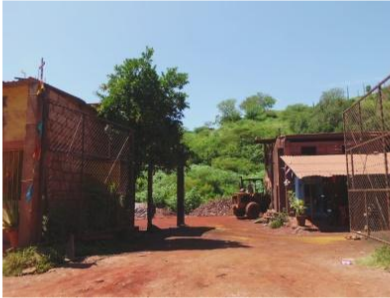
Figura 72. Fábrica de tabiques y materiales de construcción en Tlaucingo.
