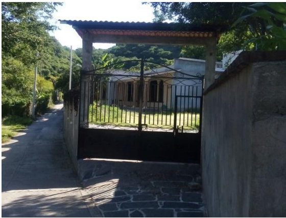
Figura 63. Estilo de construcción actual.
