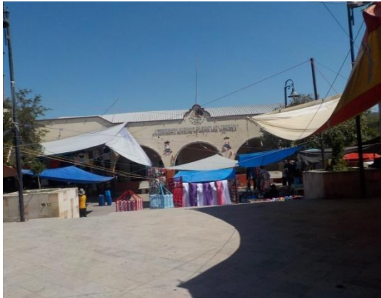
Figura 33. Presidencia auxiliar de Santa Ana Tamazola
