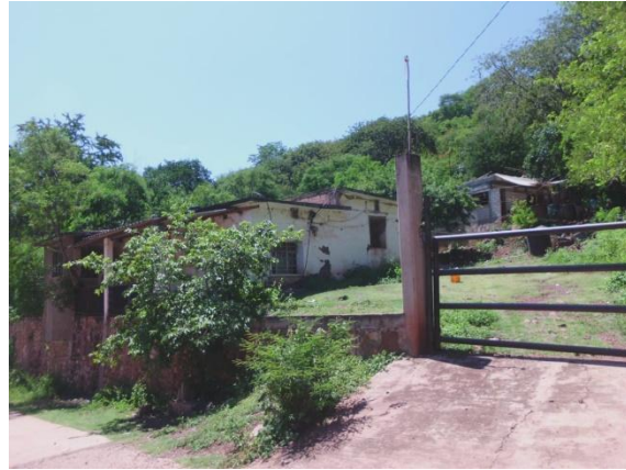
Figura 64. Construcción de adobe, otrora, típica de la región
