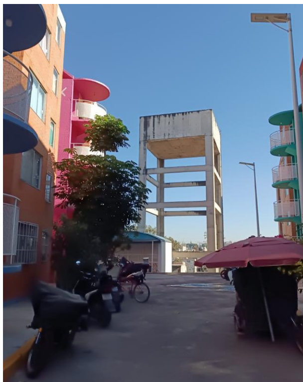
Ilustración 18. Tanque elevado del sistema de tratamiento de agua
