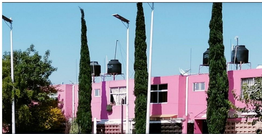
Ilustración 25. Paneles solares de alumbrado público
