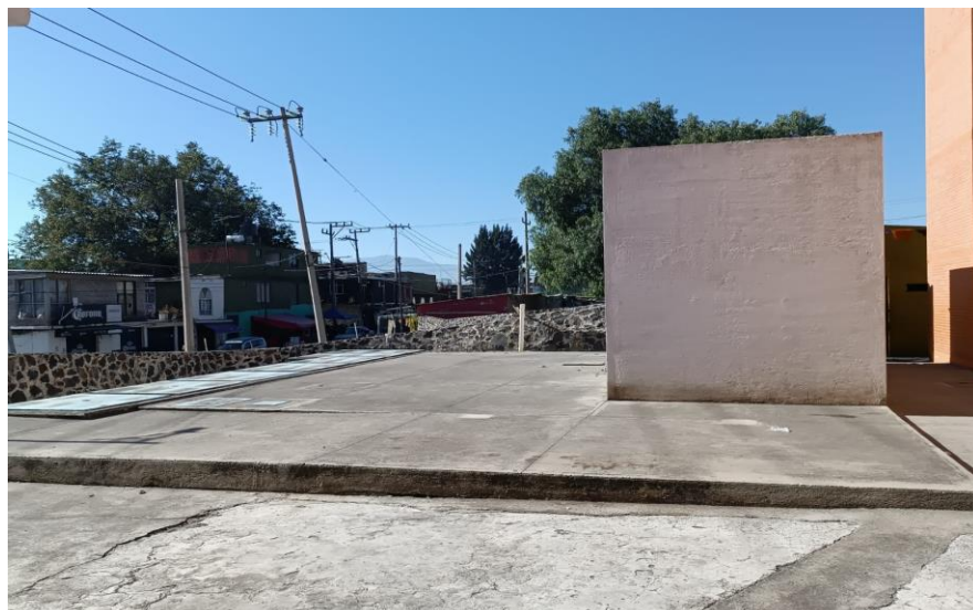
Ilustración 17. Planta de tratamiento de agua pluvial
